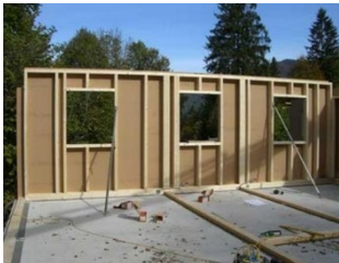
Elemente eines Gewerkes (Fertigteile Wand/Decke)
