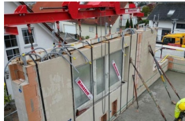
Gewerkeübergreifende Elemente (Wand-/Deckenelemente mit Fenster, Elektro- Putz ...)
