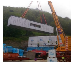
Raumzellen/Module (standardisierte Gebäude aus vorgefertigten Modulen zusammengesetzt)
